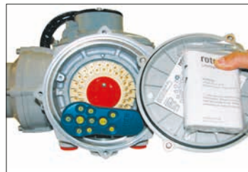
図 7.3.2 アクチュエータの端子収納部及び設定器（輸送箱内では別梱包）
